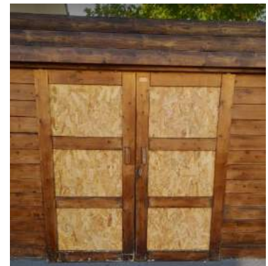
Modification et renforcement des portes du cabanon
