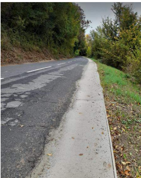
Renforcement des accotements de la route des Hédés
