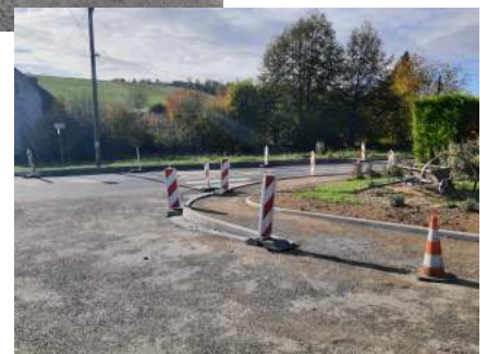
Création d'un plateau surélevé au carrefour de la route de la Bernon et du Chemin du Moulin
