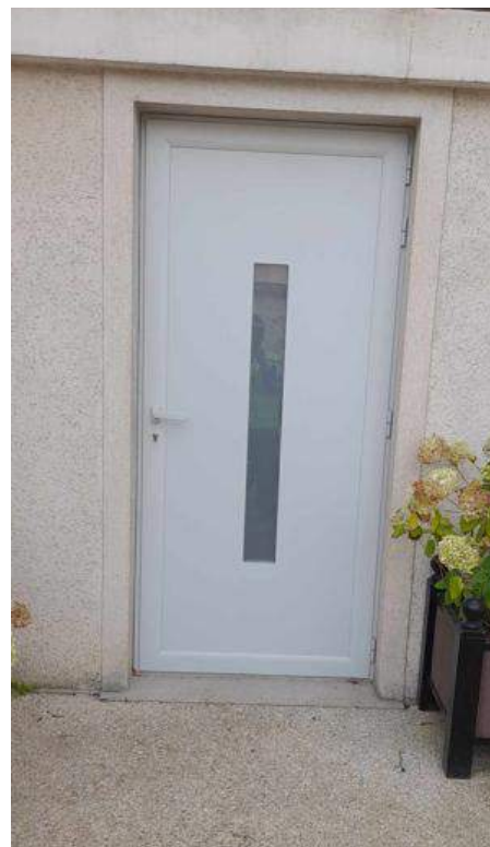
SAS ENTRÉE MAIRIE
